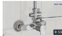
Instalacion de columnas de ducha...
