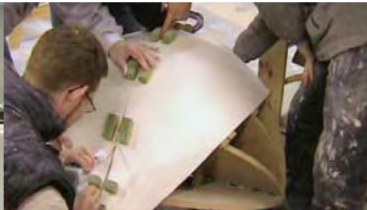
Aplicación del adhesivo DuPont™ Corian® en juntas
