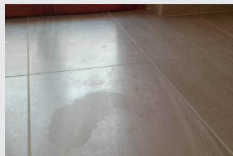
Situaciones típicas que ocurren sobre gres porcelánico debido a la formación de películas superficiales.
