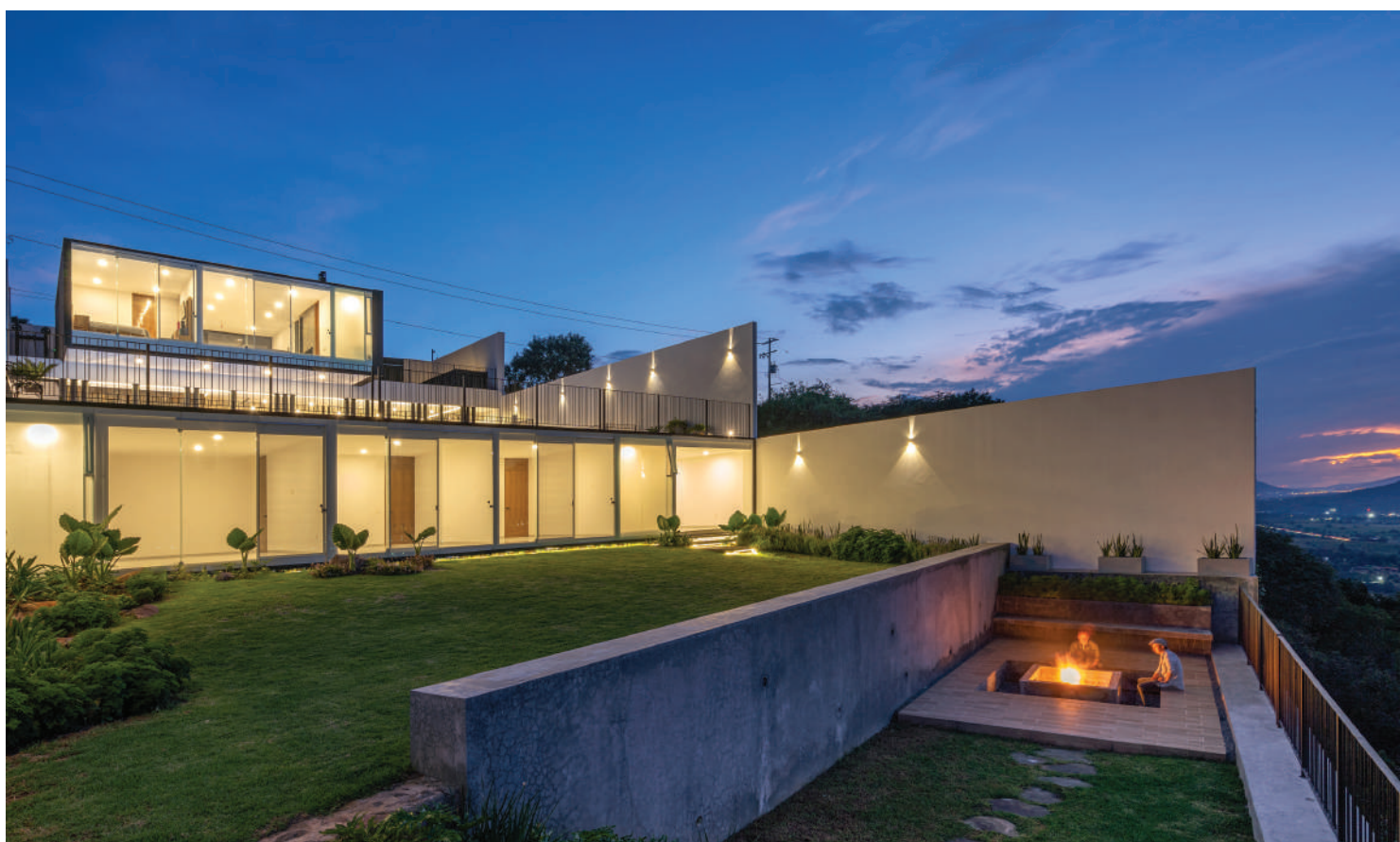
Proyecto: Casa FI-137. BLENDING DOTS ARQUITECTOS
