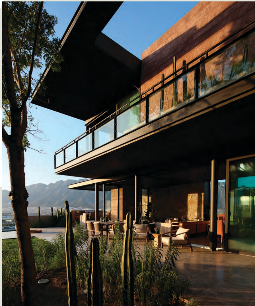
Proyecto: Casa Rocosa. LANDA SUBERVILLE
