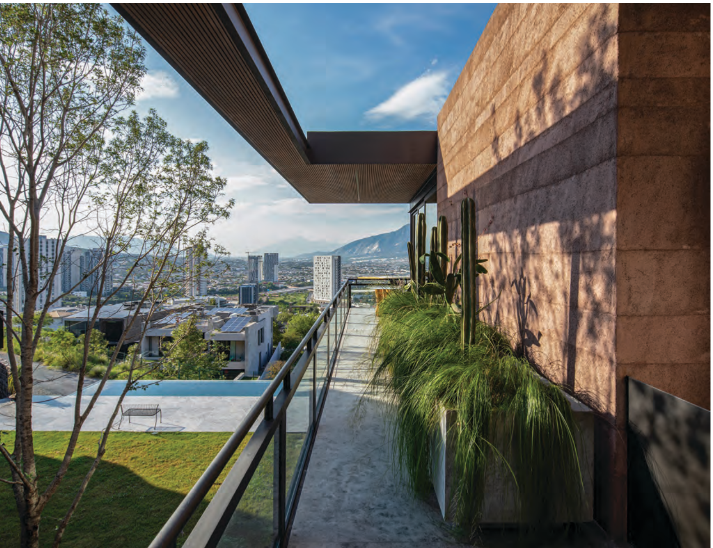
Proyecto: Casa Rocosa. LANDA SUBERVILLE
