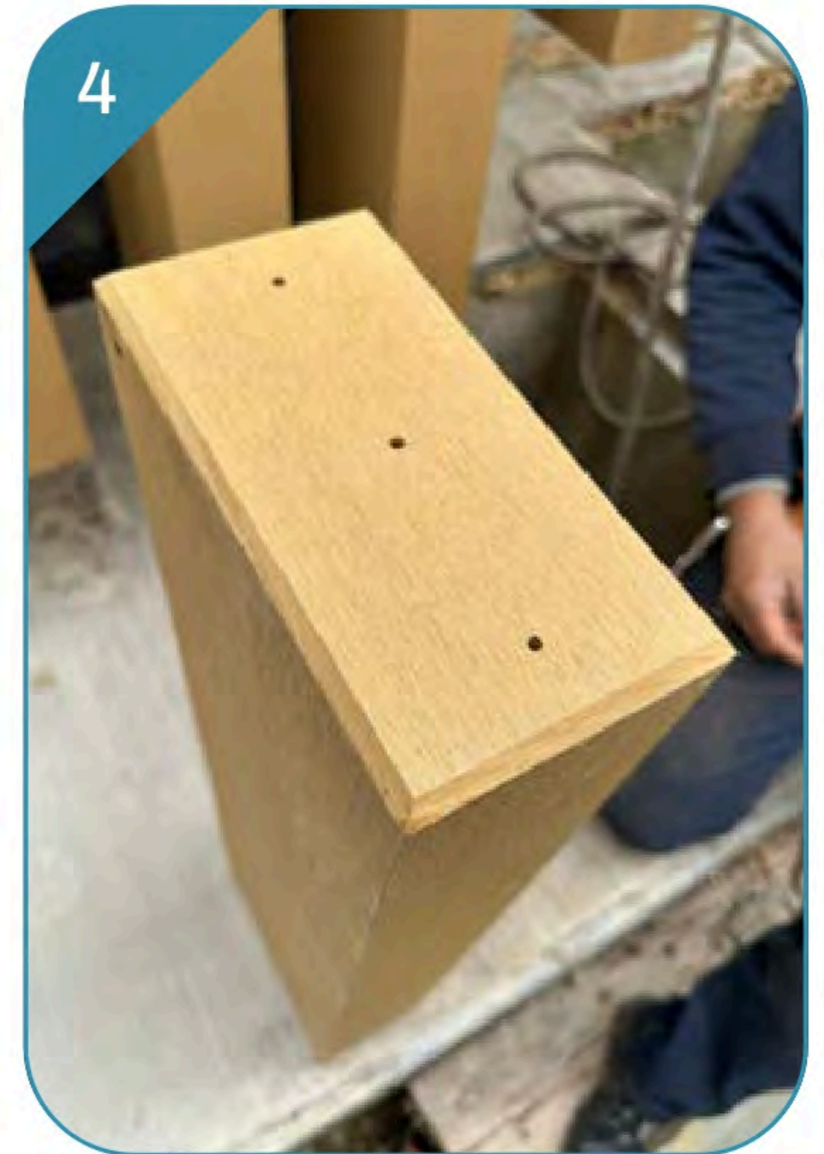
4 TAPAS DE FIJACIÓN CON DRENAJES PARA VENTILACIÓN
