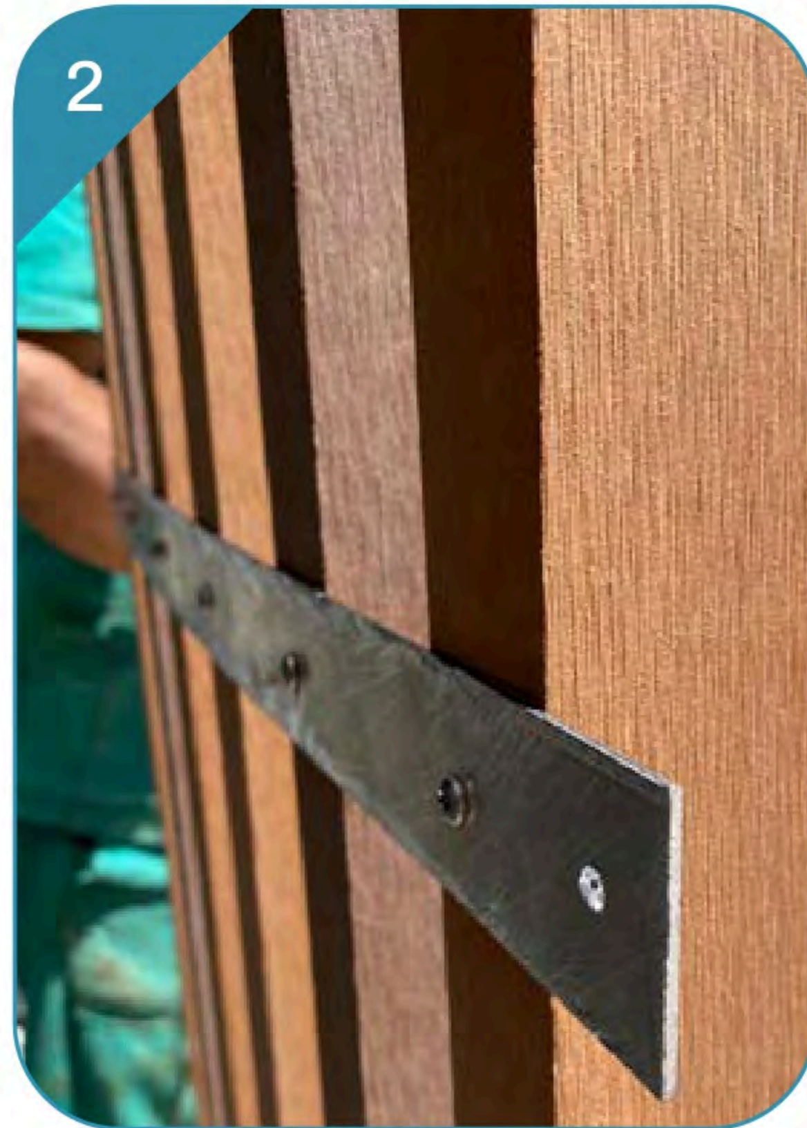
2 FIJACIÓN DE PLATINA METÁLICA
