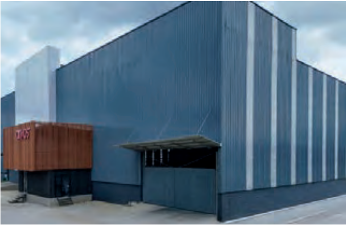
Centro logístico Celpa, Ekorooft , Colombia
