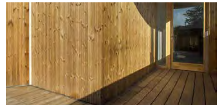
Casa privada, Thermowood deck, Finlandia
