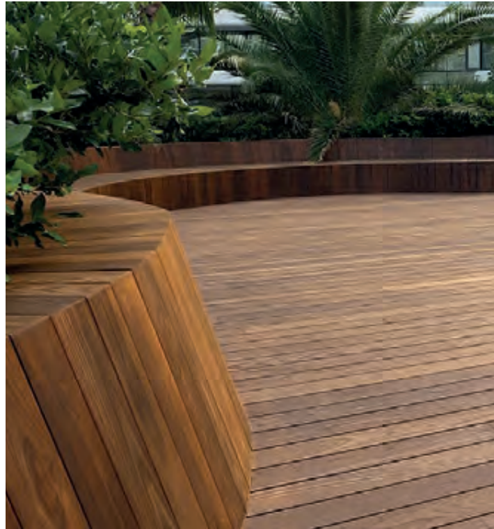
Lugar público, Thermowood deck, México
