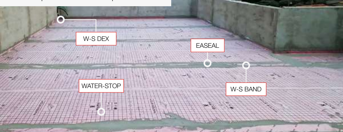
Impermeabilización de capa fina en terraza
