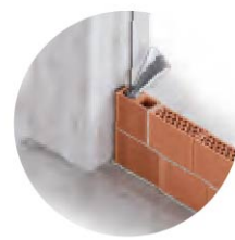
Castillos de refuerzo vertical
