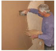
**Capa fina** El propósito principal de Headcel es facilitar la aplicación manual del revestimiento. Además, Headcel mejora la retención de agua, la resistencia y la resistencia a las grietas.
