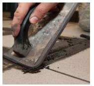
**Relleno de juntas** Headcel mejora la trabajabilidad y previene las grietas y la segregación de los materiales en el mortero.
