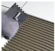
**Adhesivo para baldosas** Headcel HPMC es un ingrediente clave que mejora la retención de agua, la trabajabilidad y la resistencia a la flexión. En particular, Headcel HPMC es eficaz para aumentar tanto la adherencia como el tiempo abierto.
