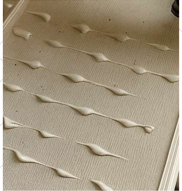
Aplica Pegamento en la base
